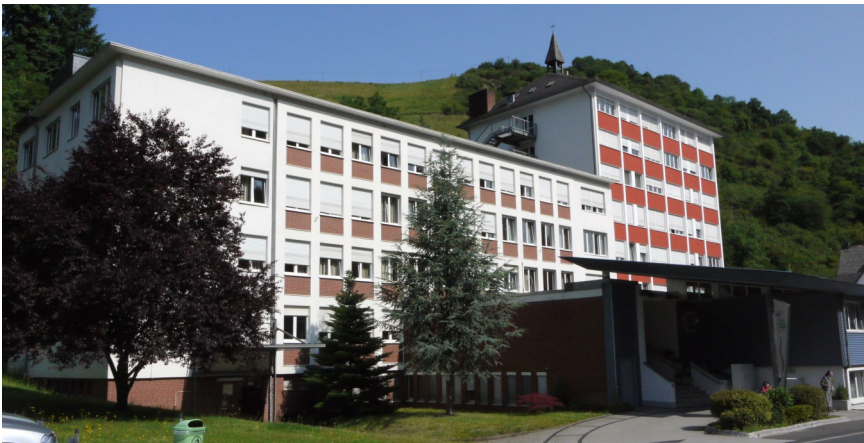
Das St. Goarer Krankenhaus wird noch für mehrere Jahre gebraucht.
