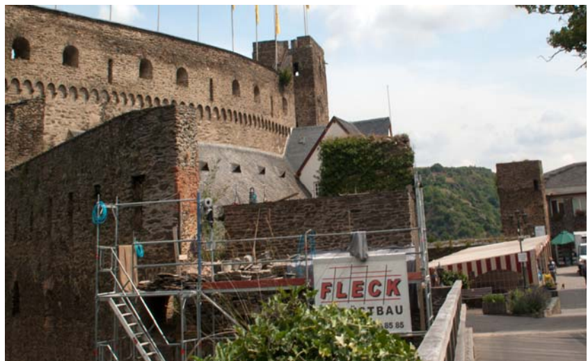
Auch zurzeit sind die Sanierungsarbeiten auf unserer Burg in vollem Gange
