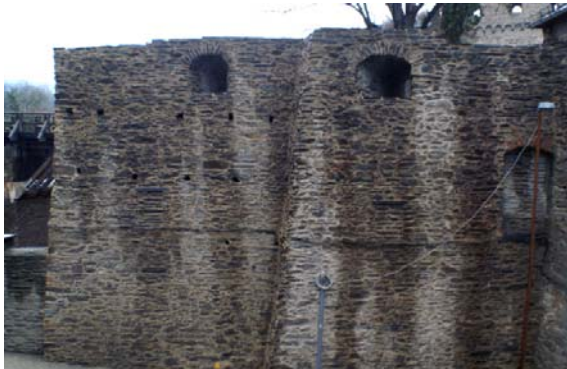
Die Außenfassade der Burg Rheinfels wurde restauriert
